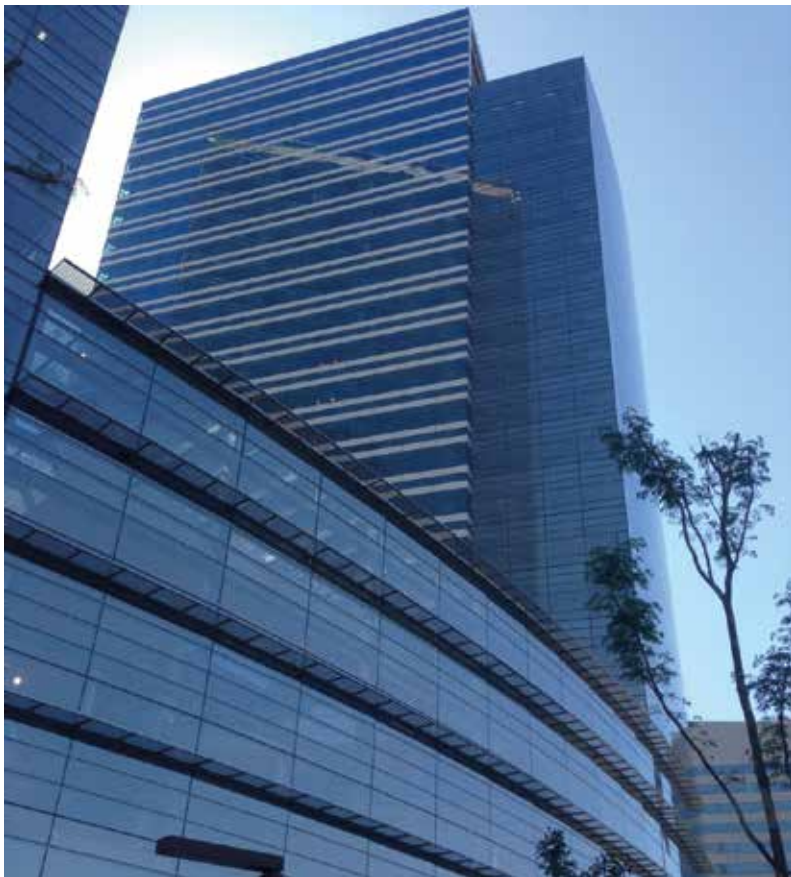
Figura 12: Edifício Multiplan Morumbi Corporate, com 50% de PAF na fachada em pele de vidro obteve certificação sustentável LEED® nível Gold. - Projeto: Aflalo e Gasperini Arquitetos
